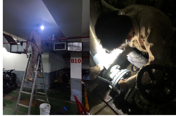
KỸ THUẬT TÒA NHÀ TRONG CÔNG TÁC BẢO TRÌ
