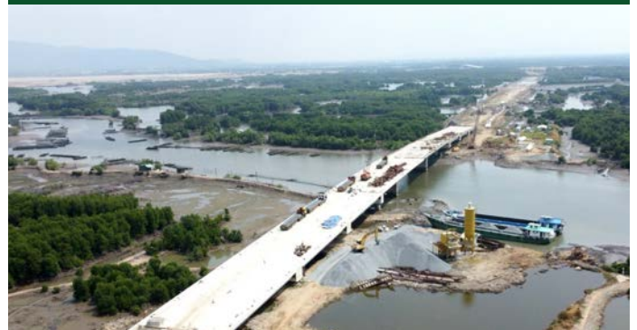
Cầu tuyến 991 - Bà Rịa Vũng Tàu Bridge route 991
