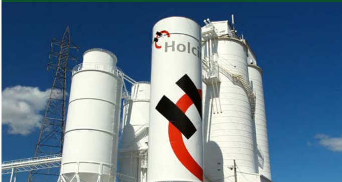
Nhà máy xi măng Holcim Holcim cement factory
