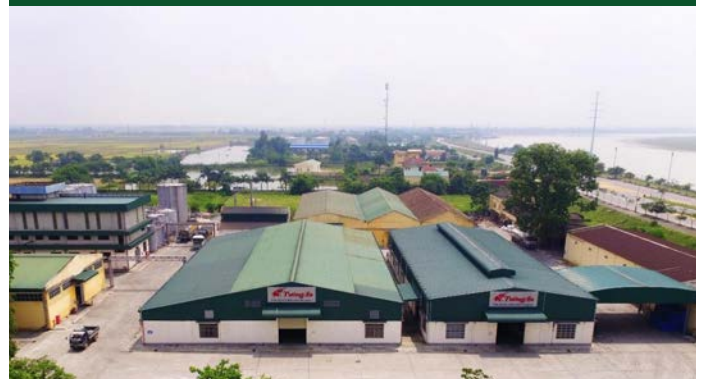
Nhà Máy dầu Tường An Tuong An oil factory
