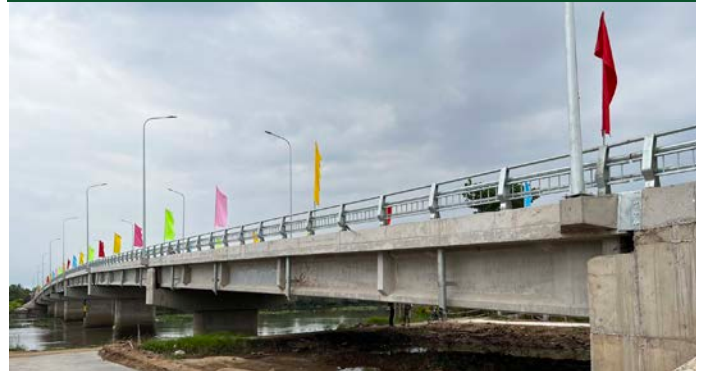
Cầu Vàm Cái Thia - Tiền Giang Vam Cai Thia Bridge
