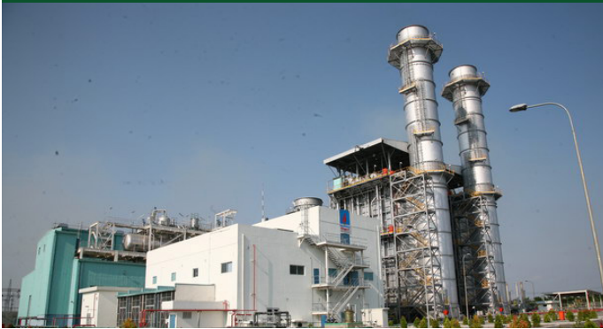
Nhà máy nhiệt điện Nhơn Trạch 1 Nhon Trach 1 Thermal Power Plant
