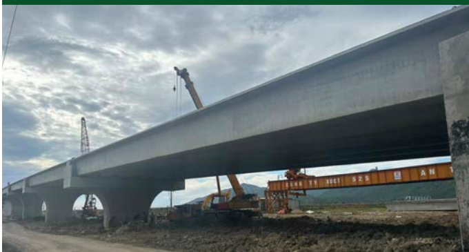
Cầu Vượt Đường Sắt Phú Yên Phu Yen Railway Overpass
