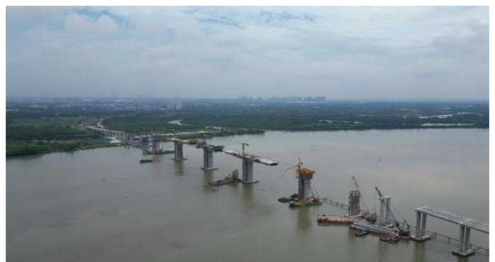
Cầu Nhơn Trạch Nhon Trach Bridge
