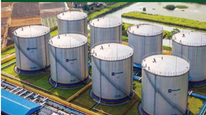
Kho cảng xăng dầu Phước Khánh Phuoc Khanh petroleum port and depot
